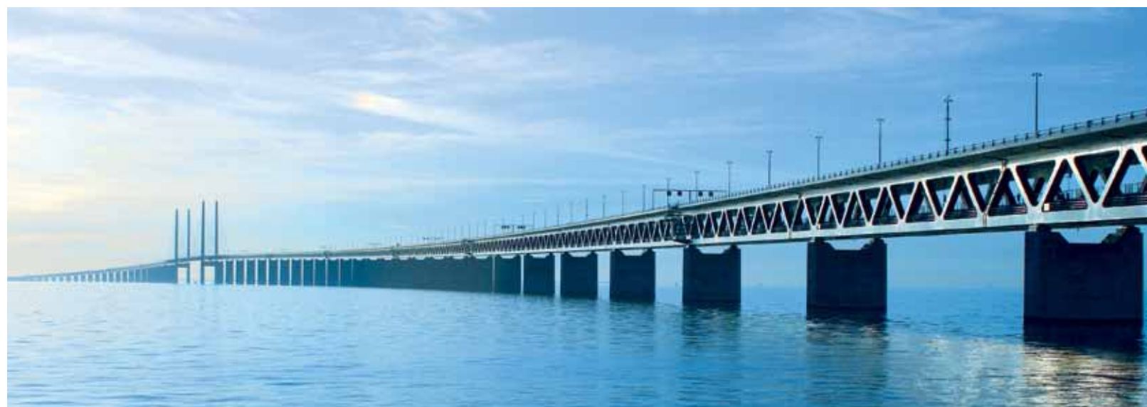
Seit Juli 2001 verbindet die 7,845 km lange Öresundbrücke Dänemark und Schweden.
